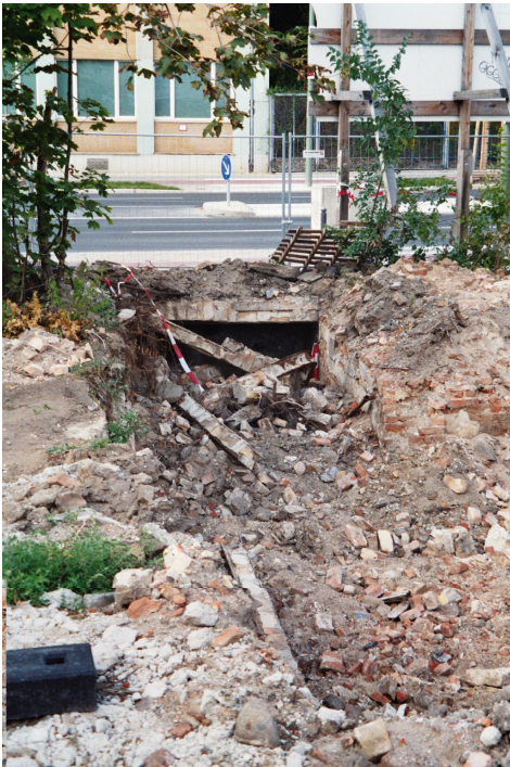
Reste des Kellers eines von DDR-Grenzern abgerissenen Hauses
