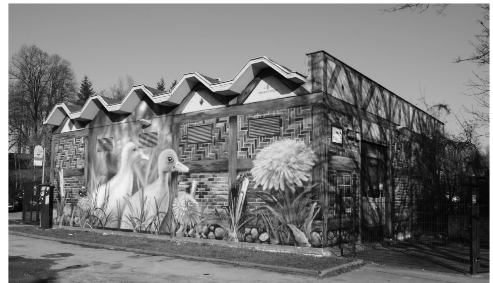
Eines der Pumpwerke, das von der DDR errichtet wurde, um die Kanalisation im Osten Berlins vom Westen der Stadt abzutrennen (Eberswalder Straße)
