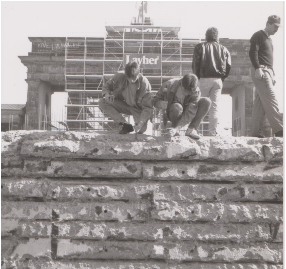
Abriss der Mauer
