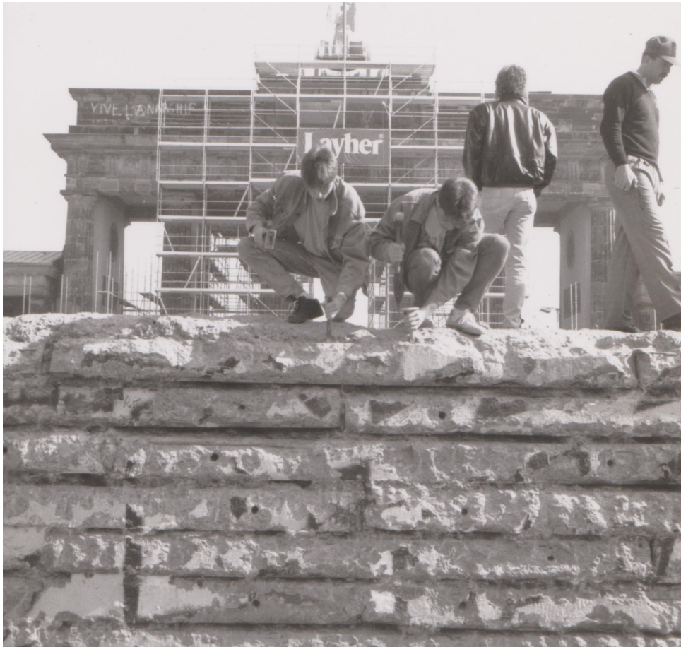
Abriss der Mauer
